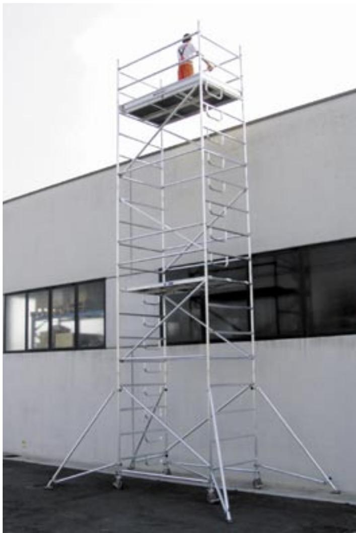
Montaggio massima altezza 9,30 m all'esterno, con minima componentistica necessaria. MOD. 140/240/9.
