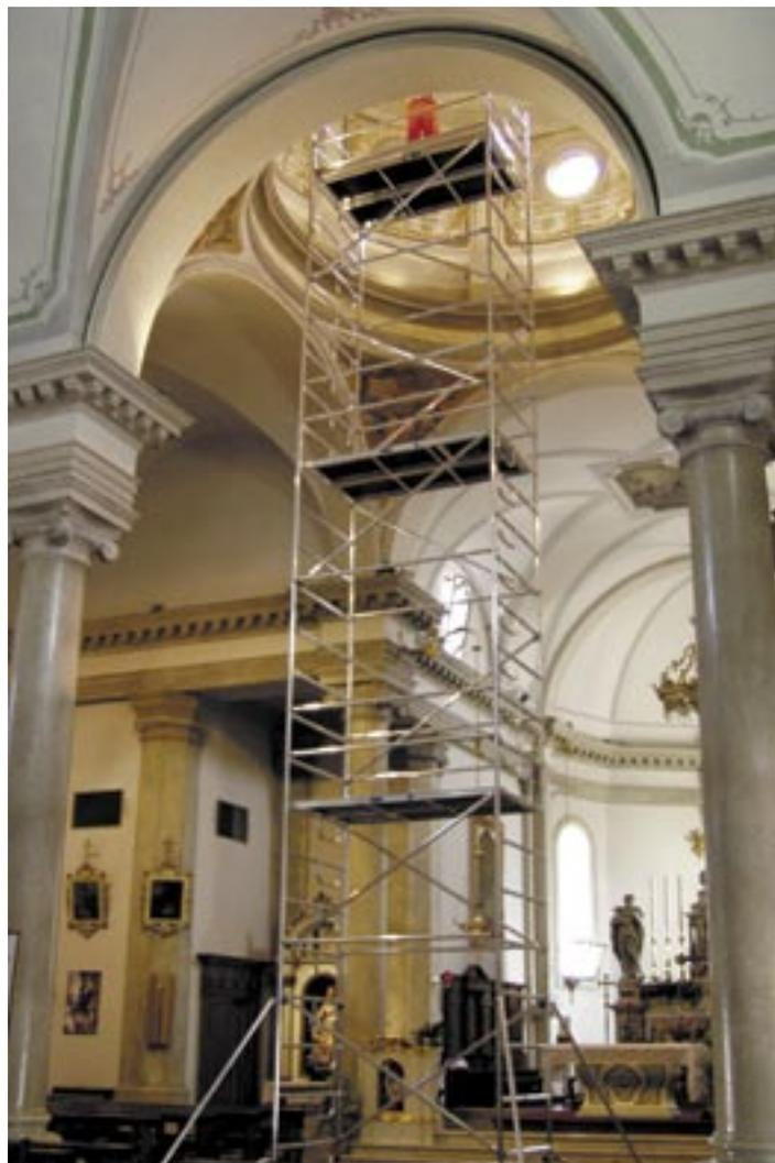
Montaggio massima altezza 13,30 m all'interno, con minima componentistica necessaria. MOD. 140/240/13.
