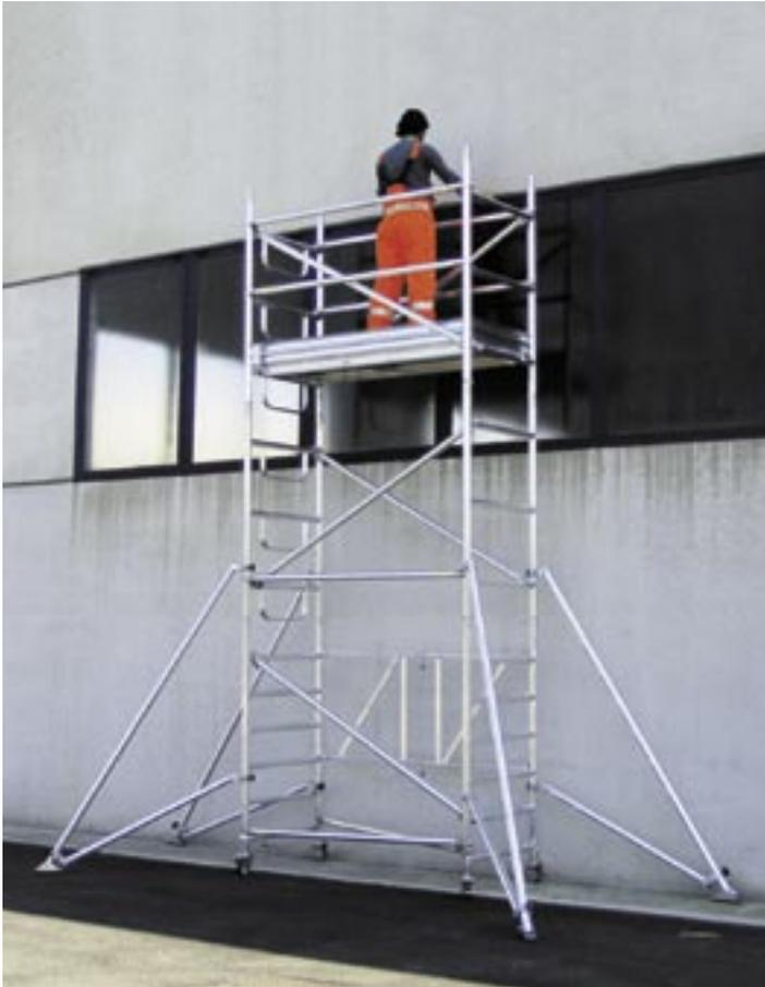
Compact di base con aggiunta di due campate da 150H a tre traversi ogni 50 cm. Su un lato aggiunta di scaletta passo 25 cm.
